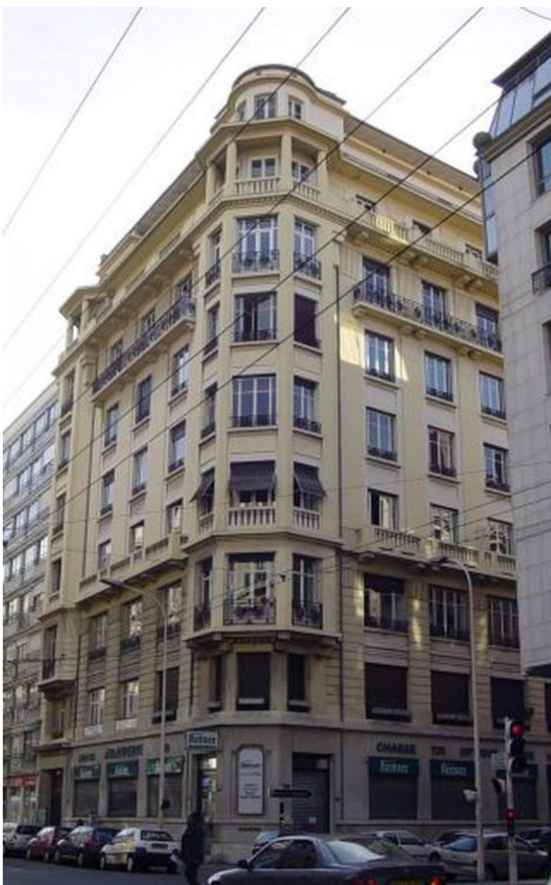
Vue générale de l'élévation
