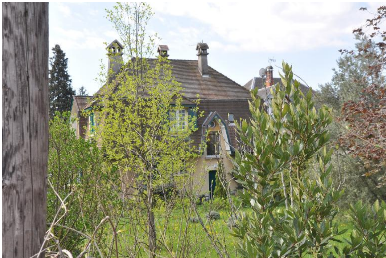
Vue depuis l'arrière
