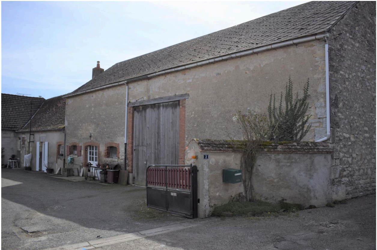
Vue du côté est, sur cour.
