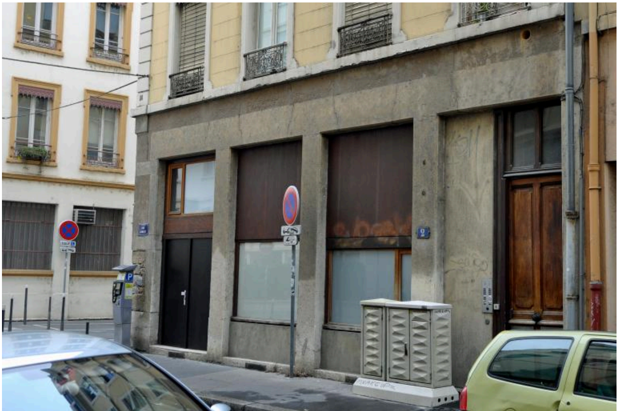
Vue du rez-de-chaussée, rue Jangot
