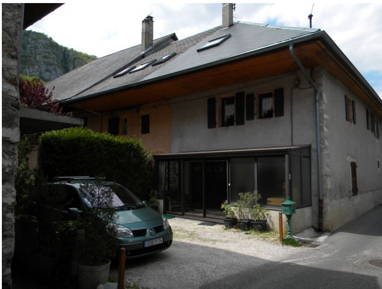
Façade sud avec l'entrée de la partie avale.
