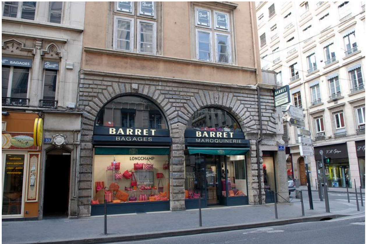
Élévation nord depuis la rue Grenette : les arcades
