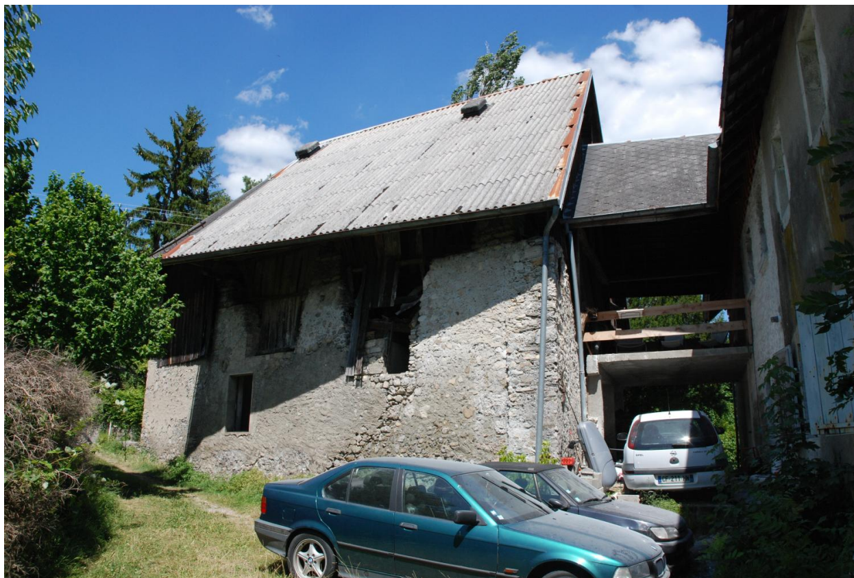
Granges-étables (2018 I1 198), élévation postérieure.
