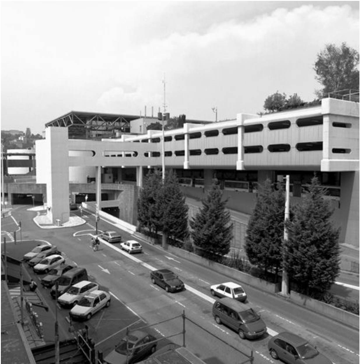
Le centre d'échanges depuis une chambre de l'hôtel Ibis situé 28, cours de Verdun-Perrache
