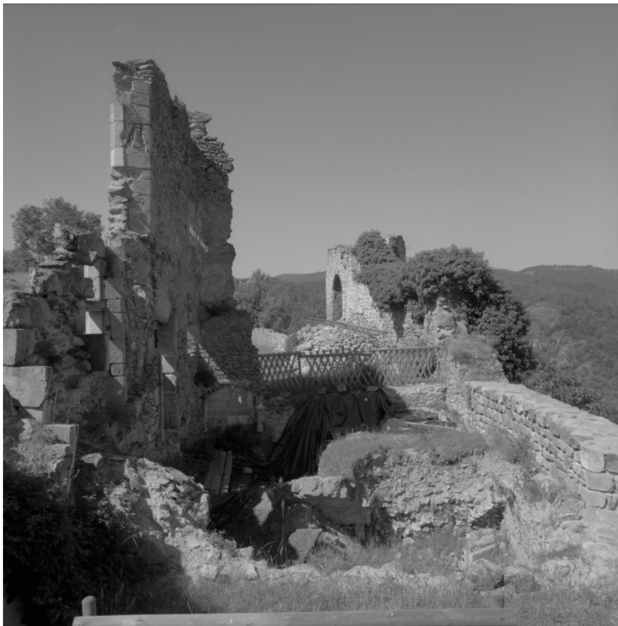
Premier baile, partie nord-ouest : vue de l'intérieur du logis dit logis du Capitaine, du nord-est.
