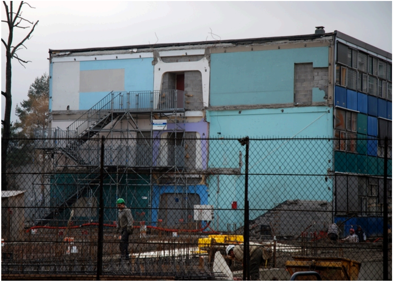
Le bâtiment de la restauration, détail d'une partie intérieure visible en cours de travaux, en 2009
