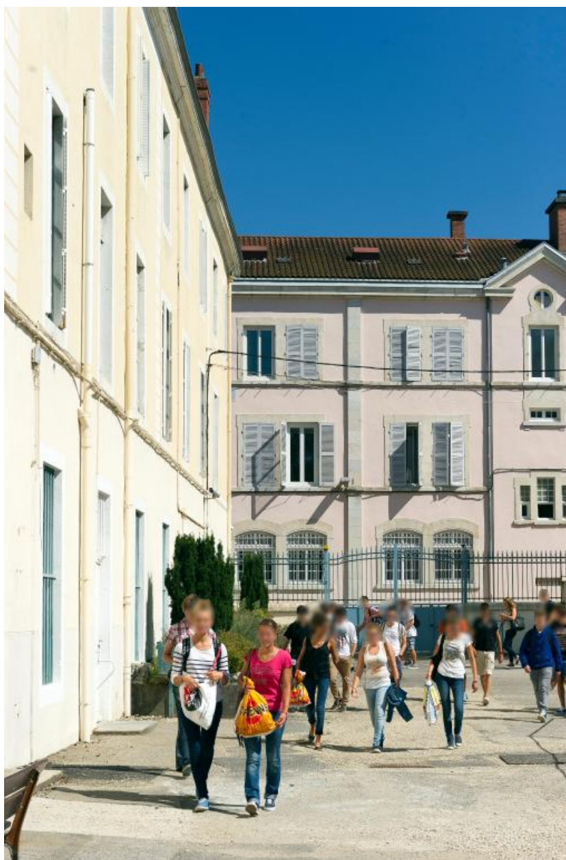
Actuelle entrée des élèves (avant travaux)
