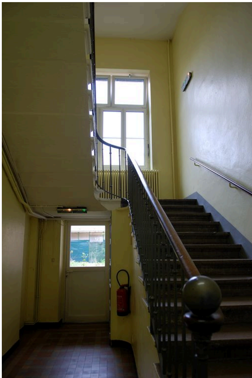
Corps de bâtiment principal : escalier nord-est
