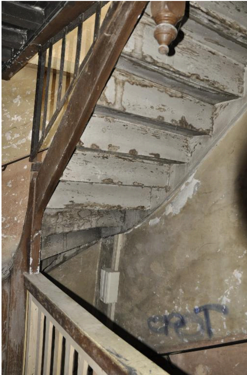
Vue de l'escalier depuis le palier
