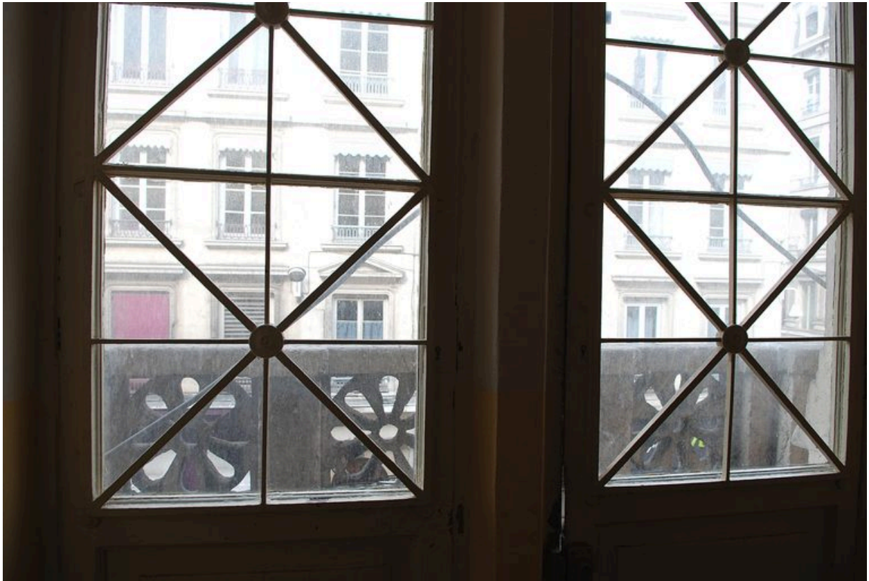
Elévation ouest : 1er étage carré, ferronnerie de fenêtre
