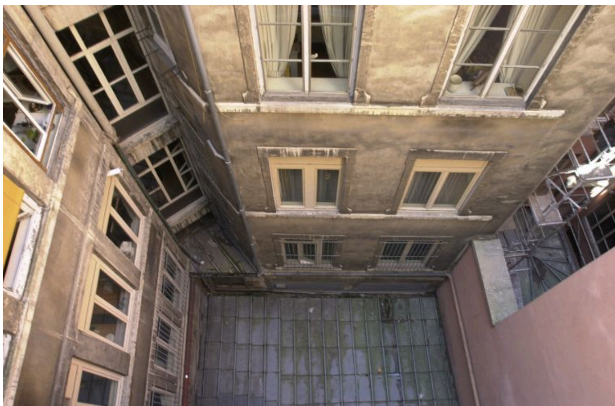
Cour vue depuis l'immeuble mitoyen
