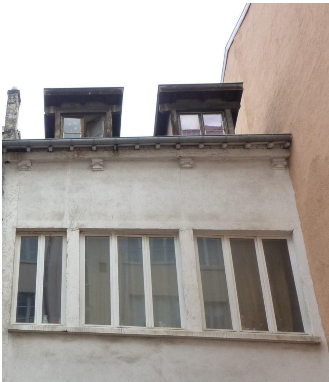
Détail baies dernier étage sur cour
