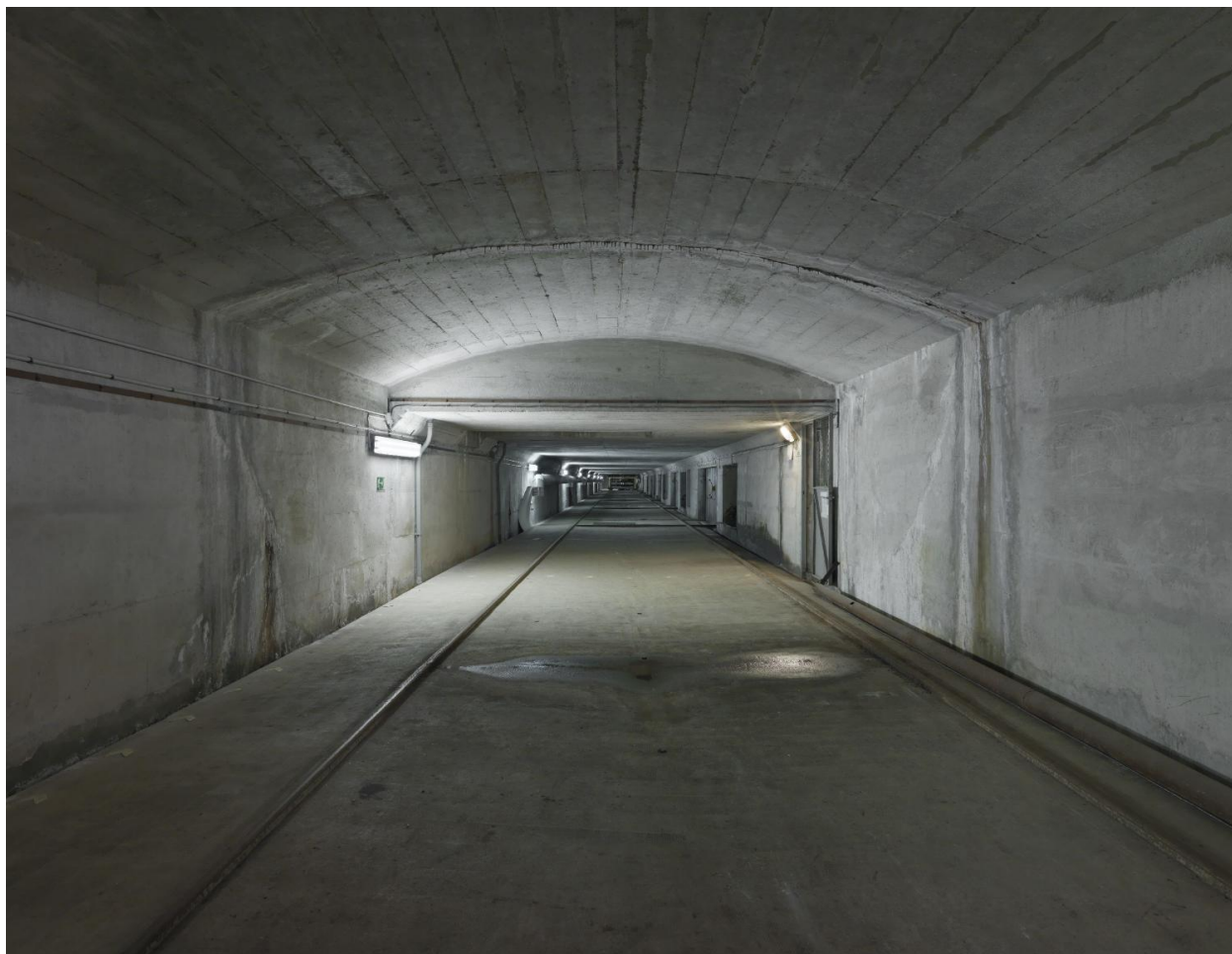
Galerie de manutention des roues en point bas de la centrale
