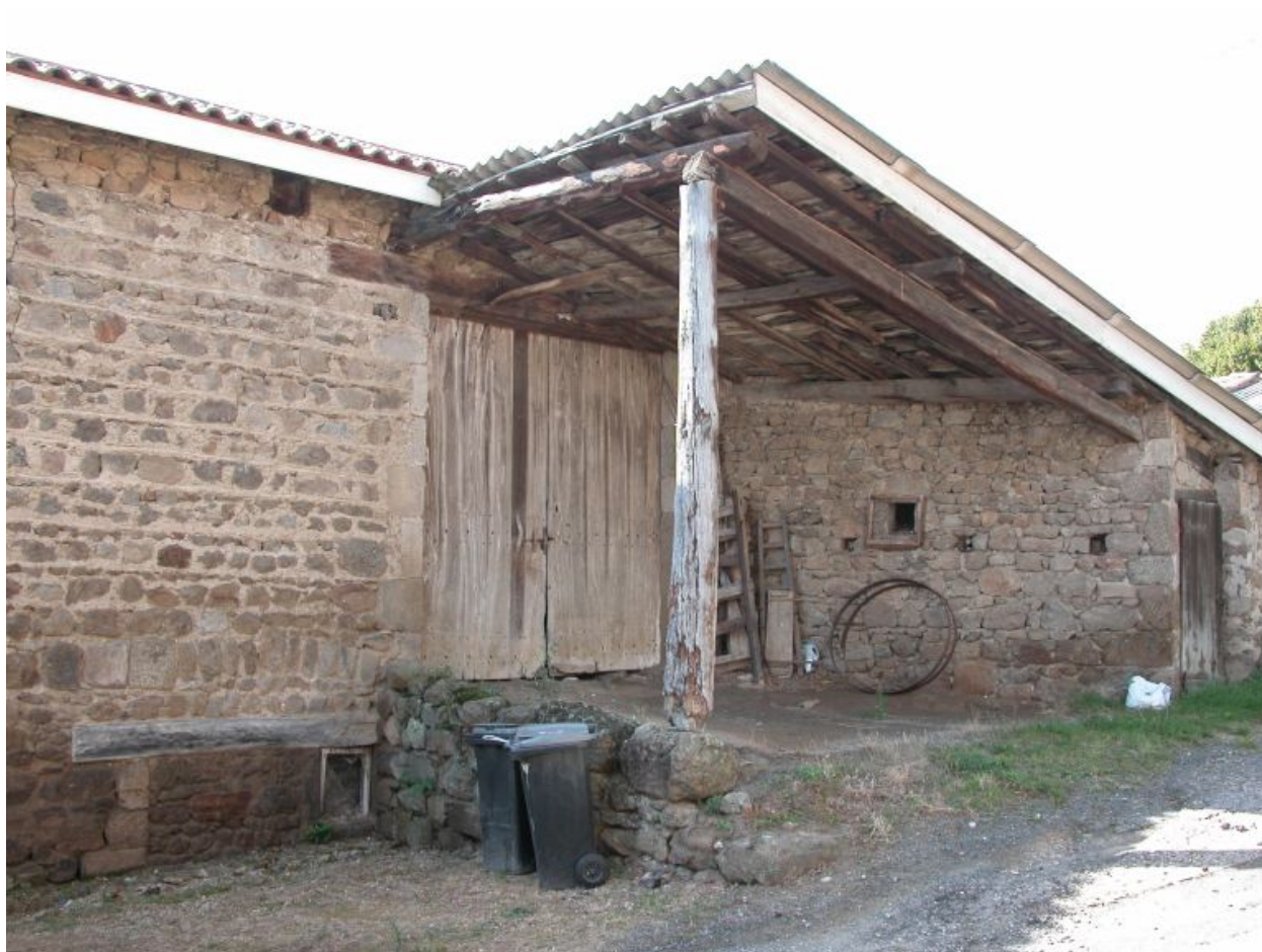
Vue d'ensemble du portail nord d'accès à la grange, couvert par un auvent en bois.
