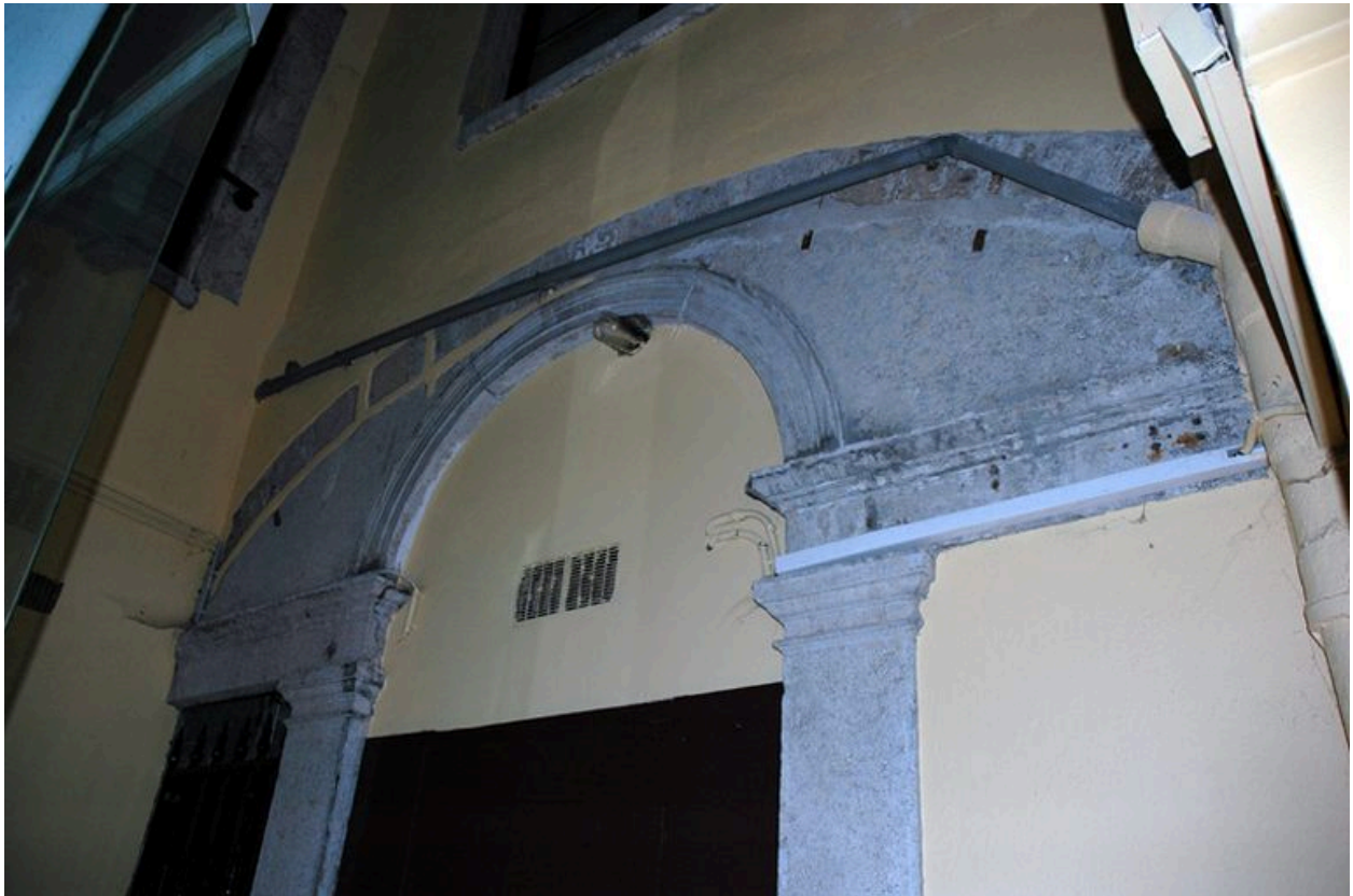
Baie située dans la cour accessible depuis la rue de la Monnaie : partie supérieure
