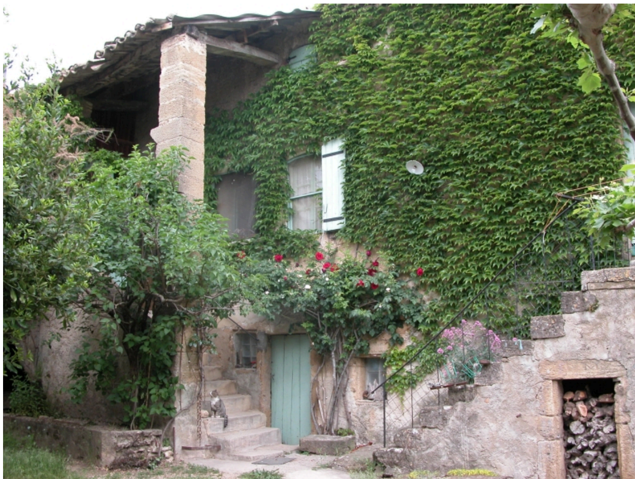
Elévation sud du premier logis et vue partielle du second.
