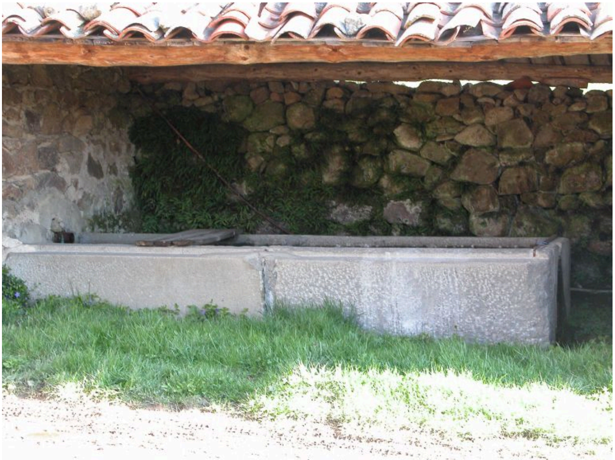
Maisonny (le), G2 426. Vue d'ensemble d'un bassin.
