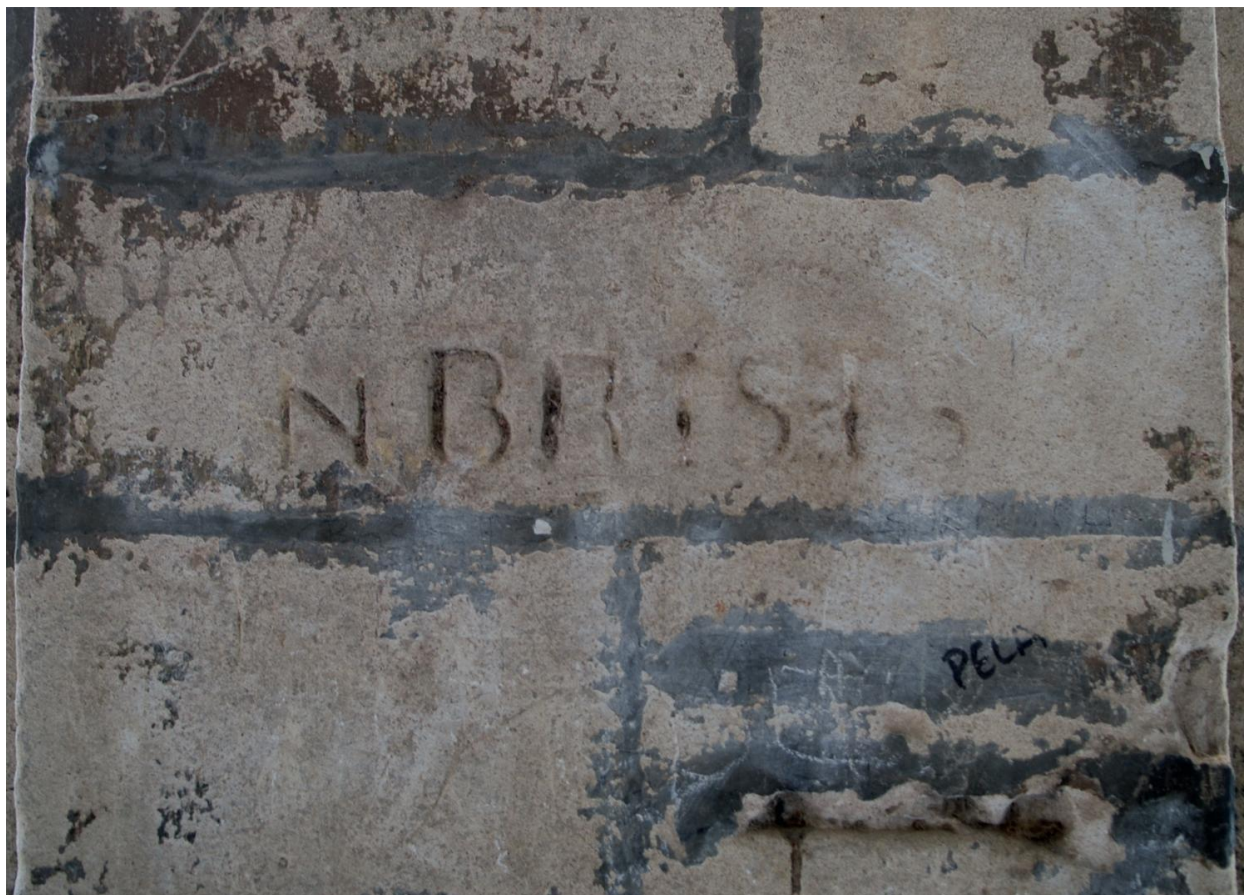
Bâtiment A, galerie sud : graffiti ancien sur un autre pilier
