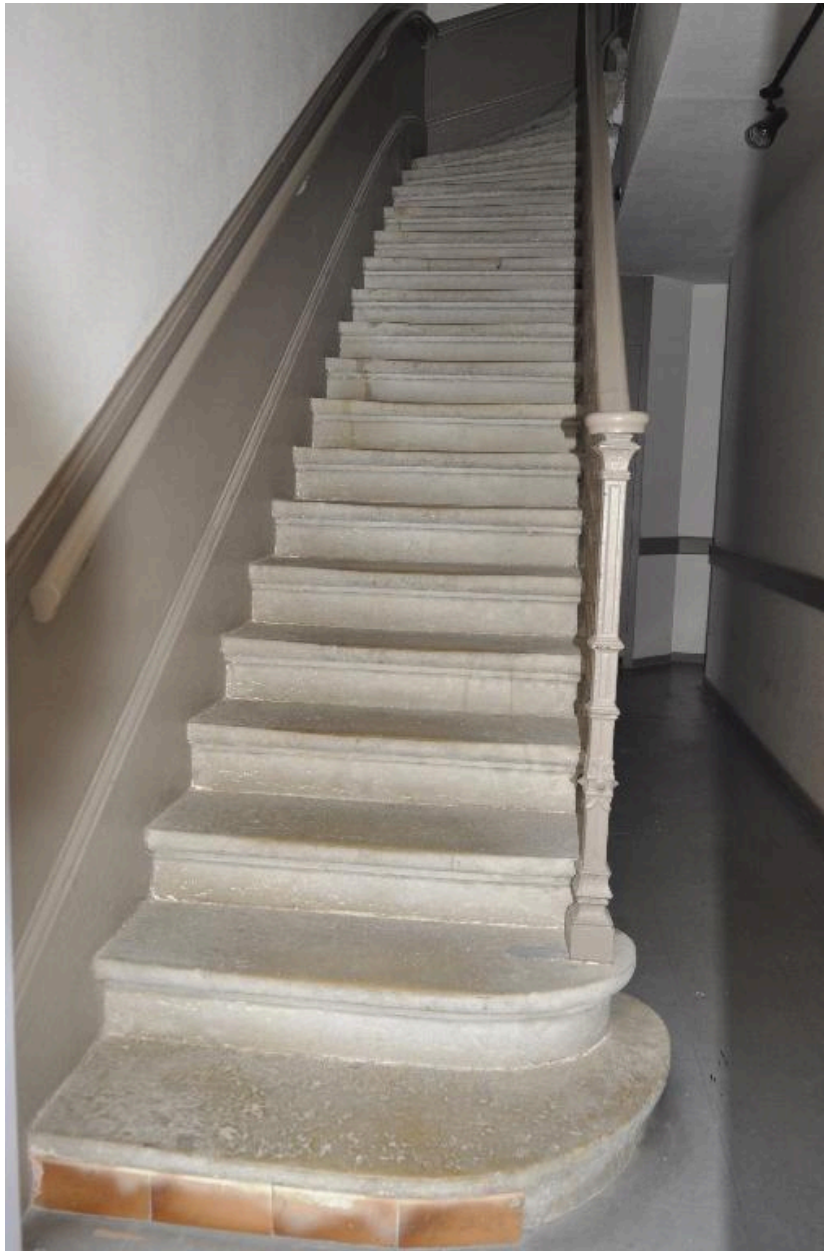
Vue intérieure : première volée de l'escalier en revers de façade
