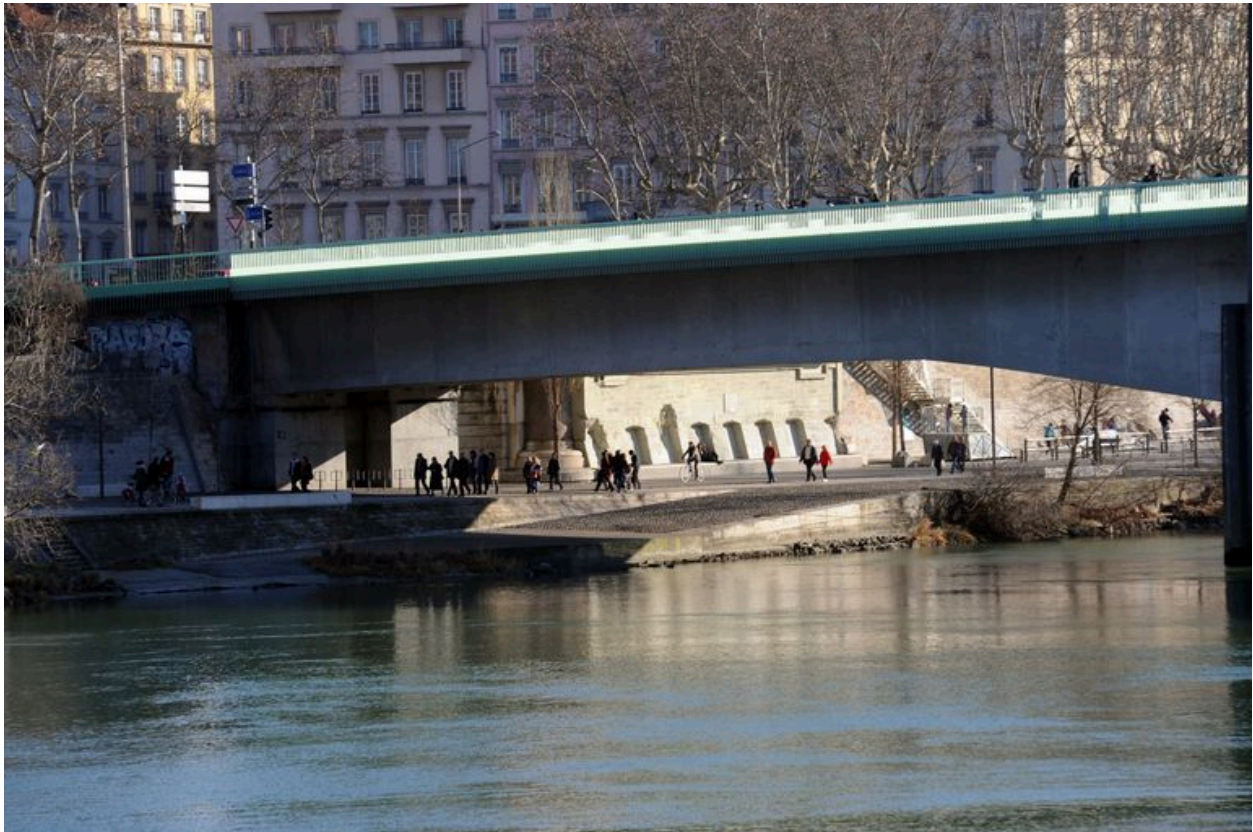
Vue partielle, travée gauche, face amont (depuis la rive droite)
