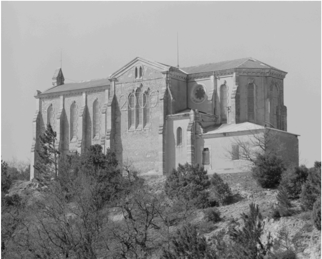
Vue d'ensemble, prise de l'est.
