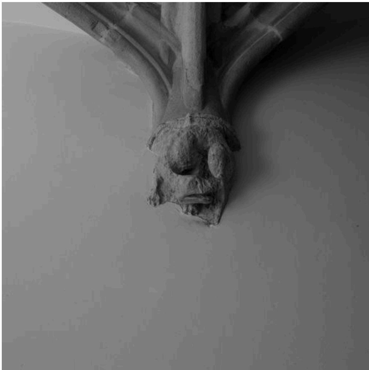
Voûte de l'allée, détail du culot 6
