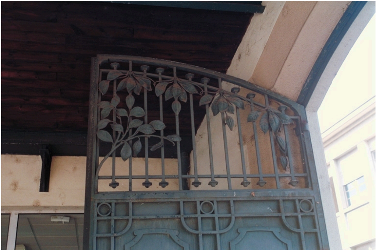
Détail ferronnerie du portail : vue d'ensemble partie haute
