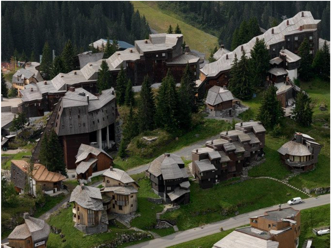
L'Araucarya et le Thuya depuis le nord. Les toitures en cascade
