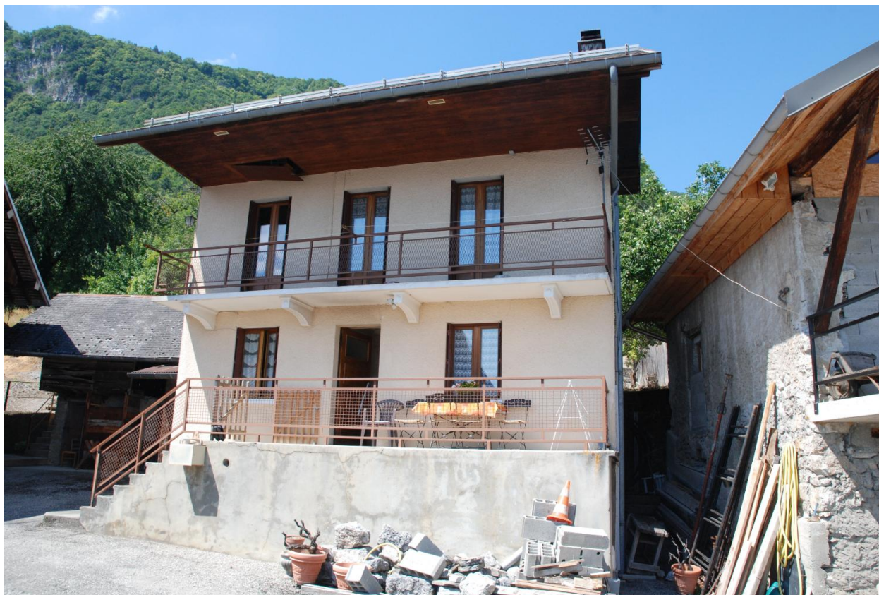
Maison de vigneron (les Allues-dessous, 2018 YE 125).
