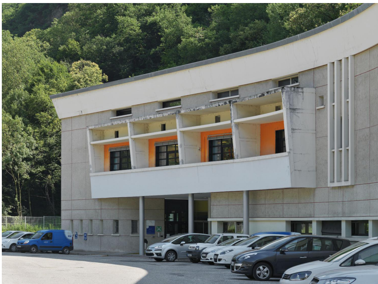
Détail façade du bâtiment administratif de la Centrale de la Bâthie
