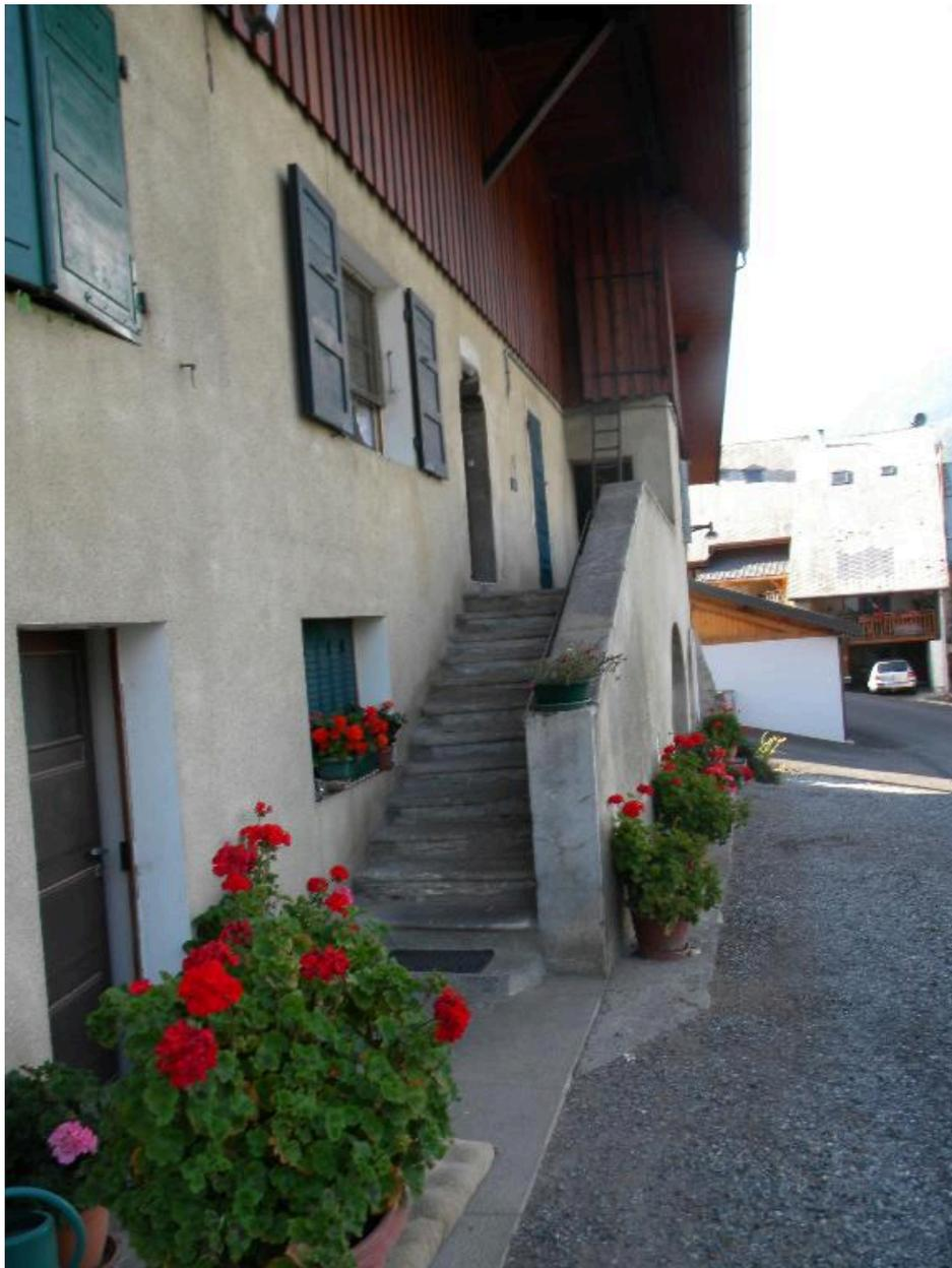
Vue de la montée d'escalier maçonnée au-dessus d'une double loge.
