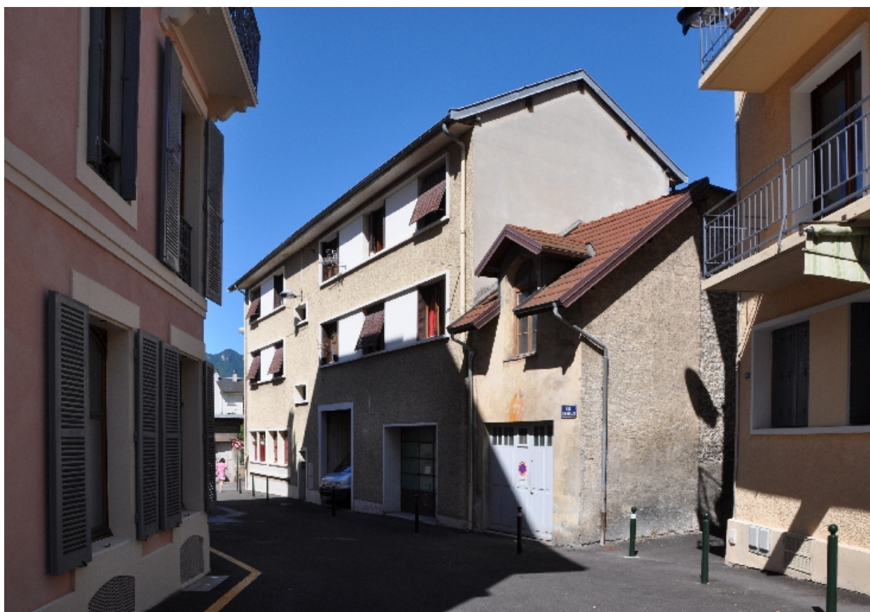
Façade sud de l'immeuble
