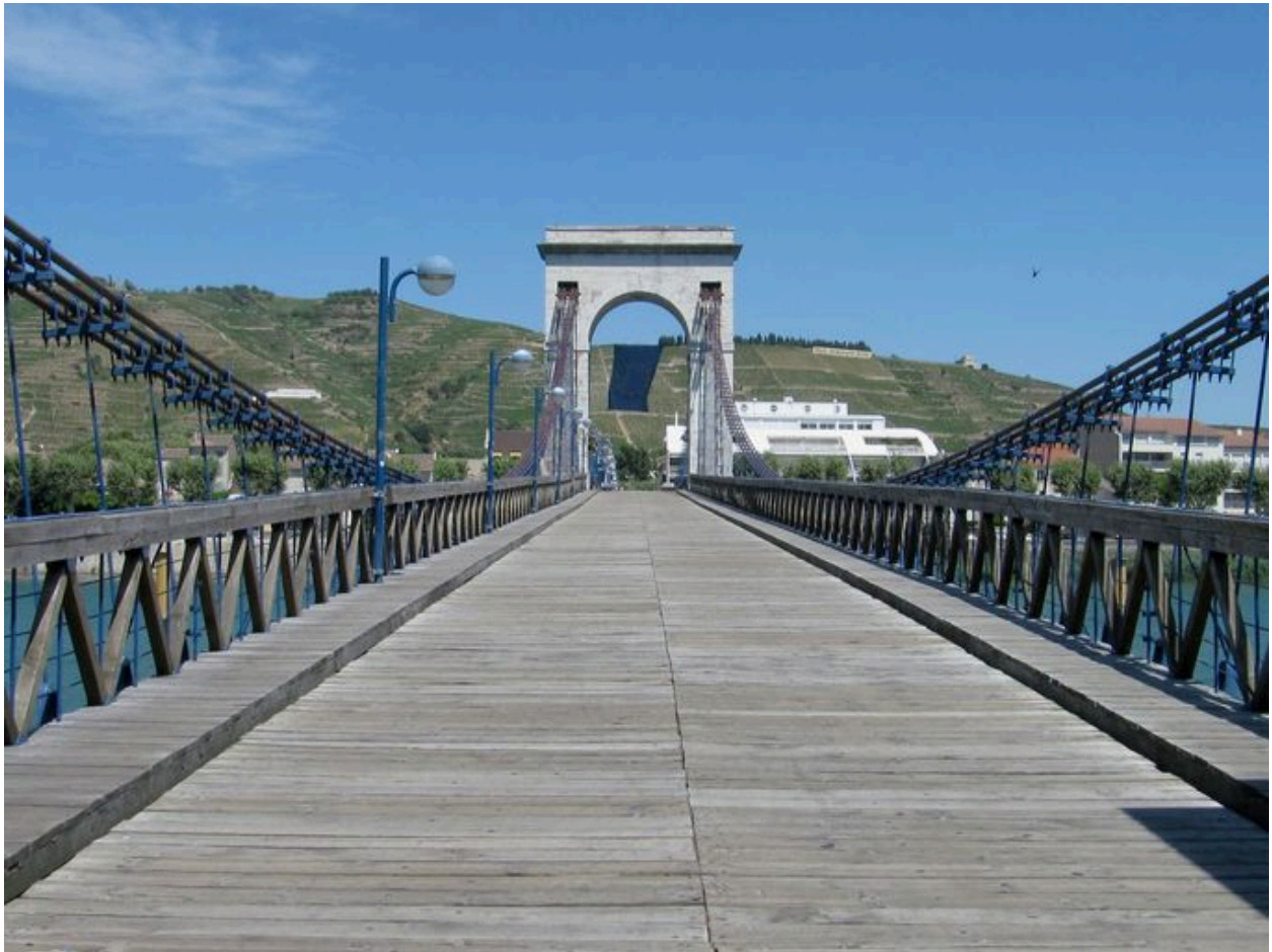
Vue partielle, de dessus, voie piétonne, pile centrale (depuis la rive droite)
