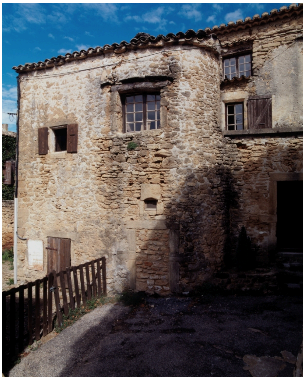
Margerie, traverse du castel, vue est du logis de la ferme (C3 703)
