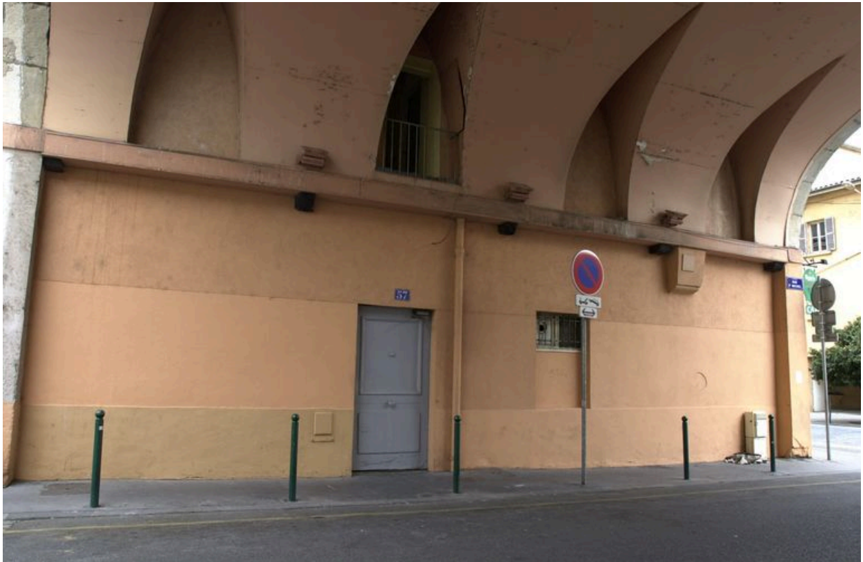
Entrée de l'immeuble sous le passage couvert, rue Saint-Michel
