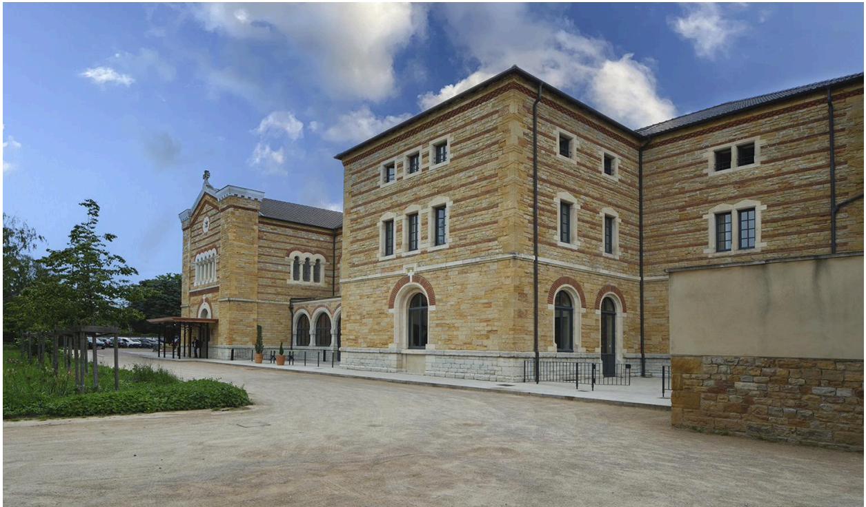
Élévation postérieure depuis l'ouest en 2024
