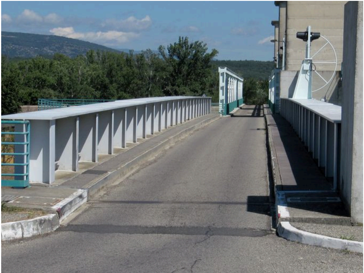
Pont sur la nouvelle passe navigable : chaussée du pont
