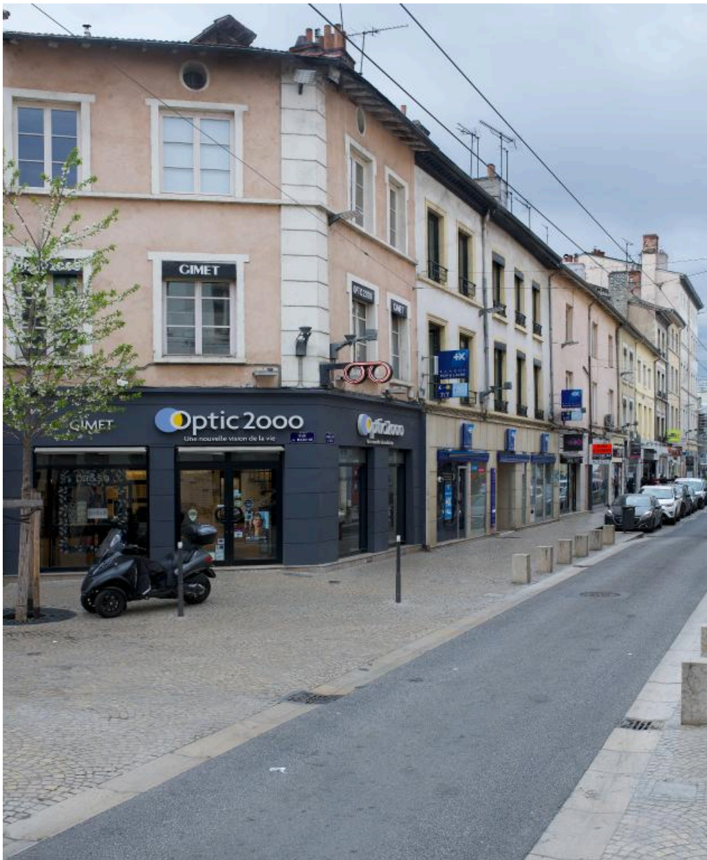
Vue d'ensemble des maisons Cointeraux en alignement sur la rue de Vaise, depuis le sud
