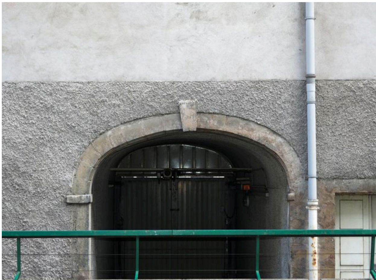
Élévation postérieure, vue partielle du passage cocher
