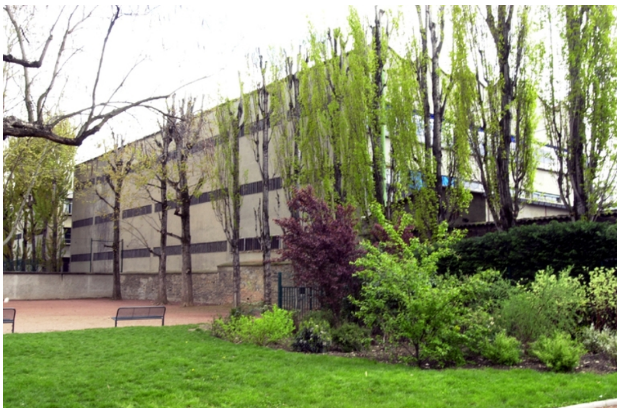
Atelier vue sud (arrière)
