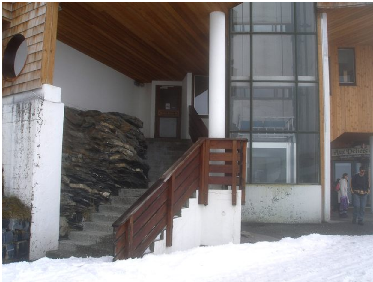
L'entrée sud de la résidence au pied de l'ascenseur public
