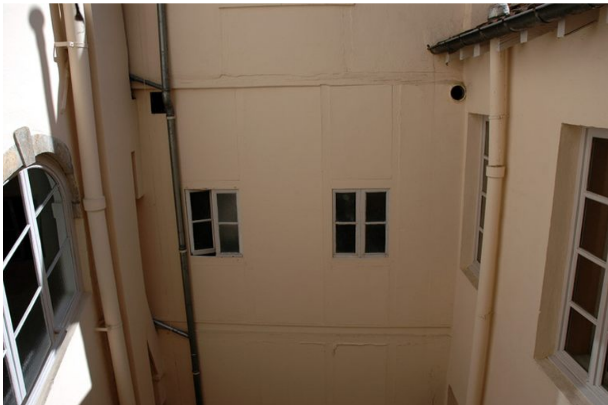
Couvent : 12 place Antonin-Gourju, vue de la galerie de service de l'immeuble
