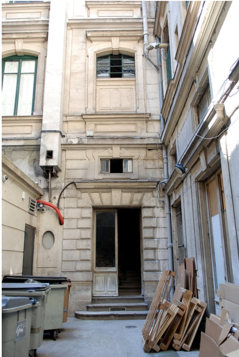
La cour : élévation sud, détail
