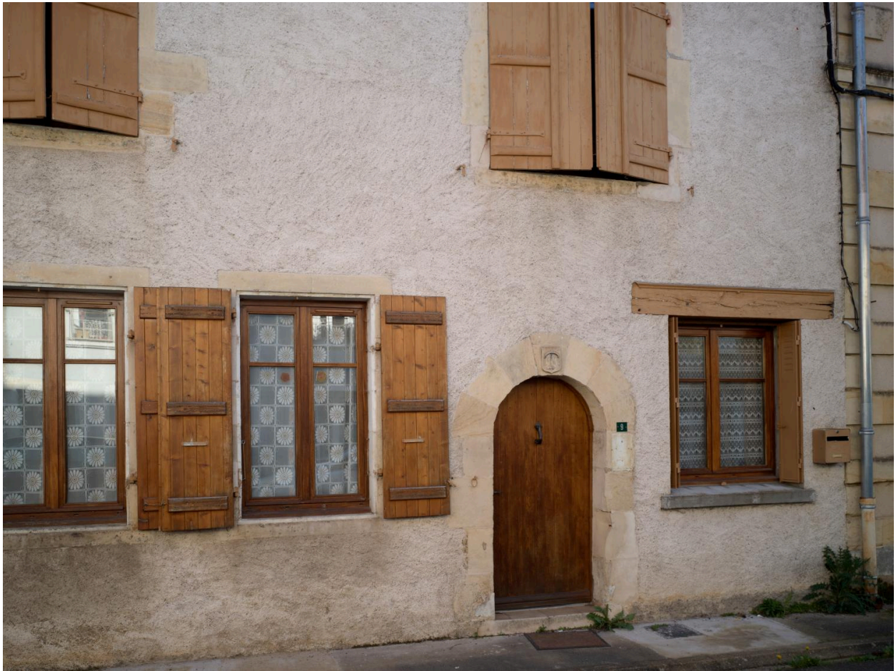
Maison, 9, rue Bourbon. Parcelle cadastrale B01 : 138, vue générale de la façade.
