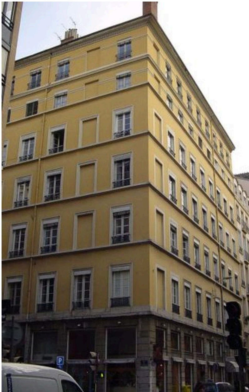
Vue générale de l'élévation sur rue
