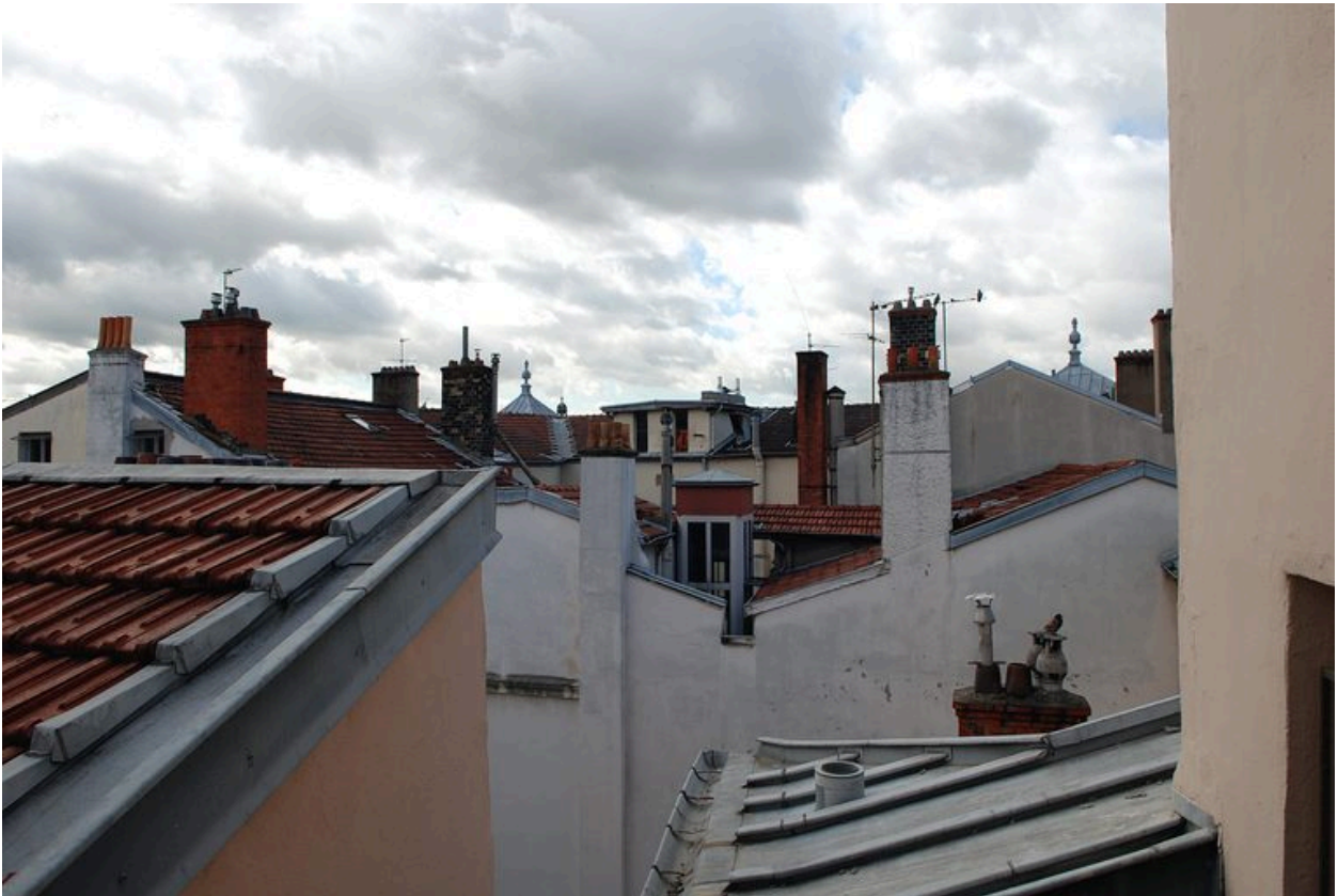
La toiture depuis le 41 rue de Brest
