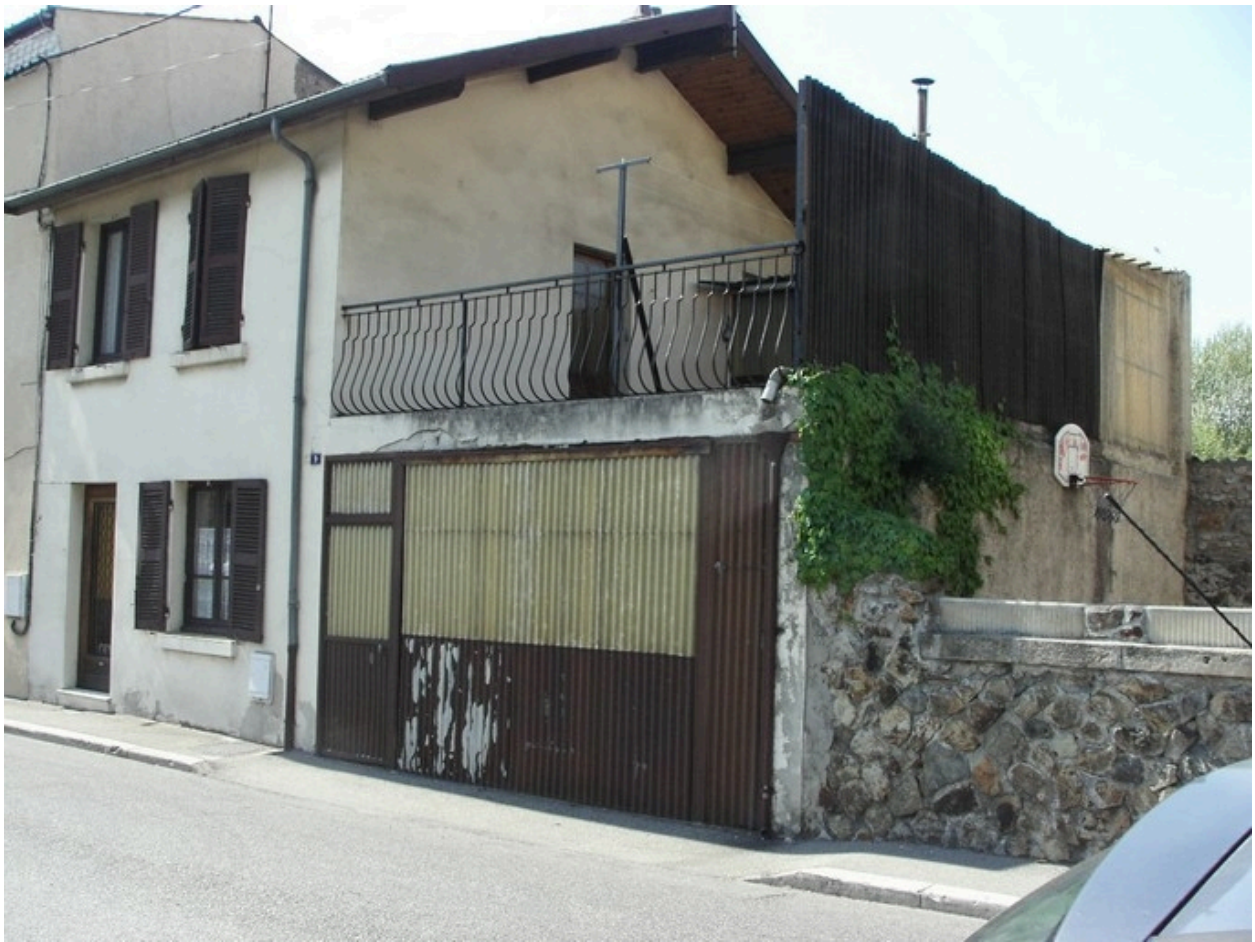
façade sud est
