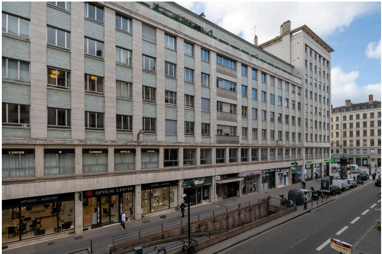
Vue partielle de l'élévation dur Childebert
