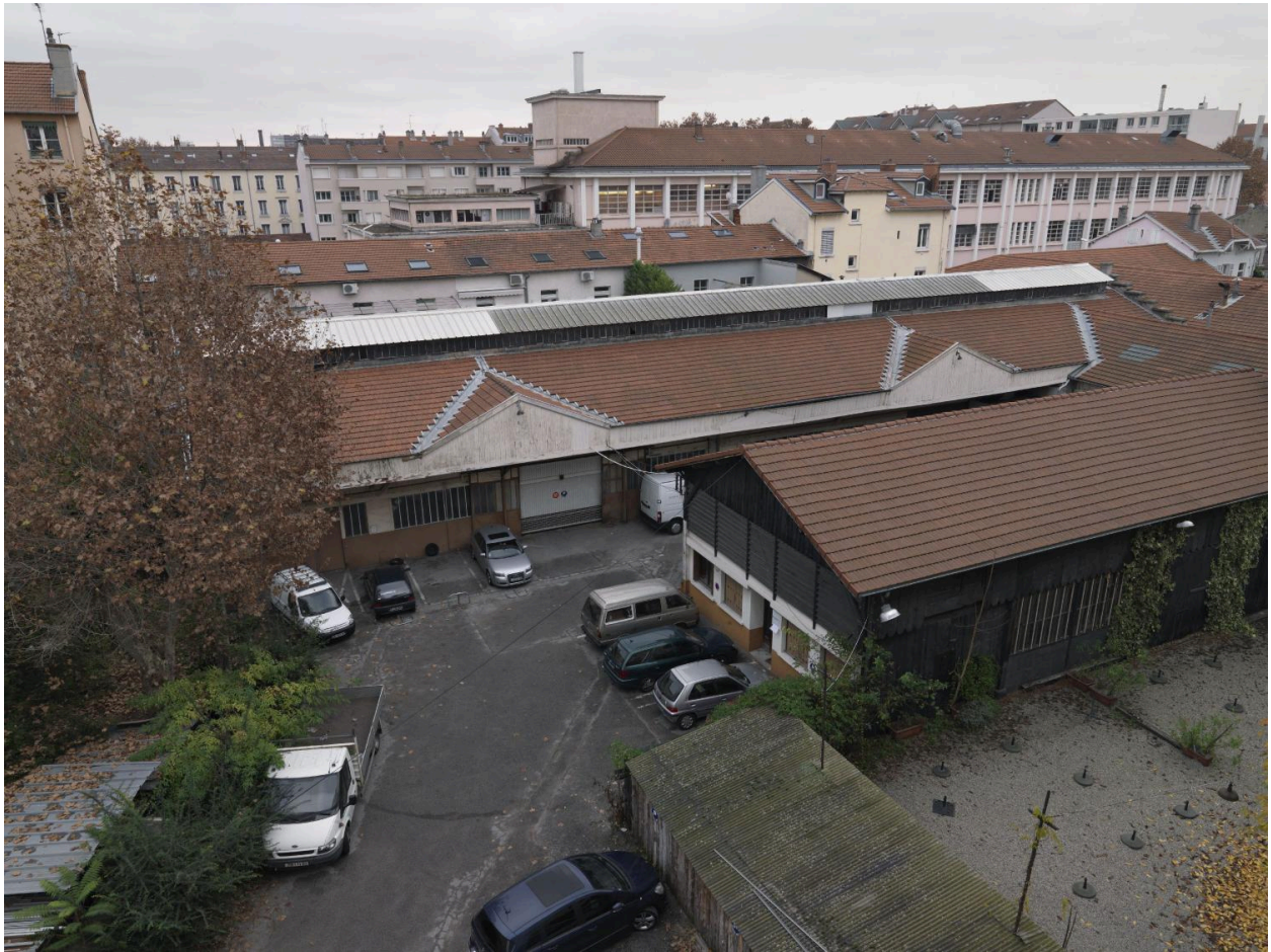
Vue d'ensemble zénithale du site
