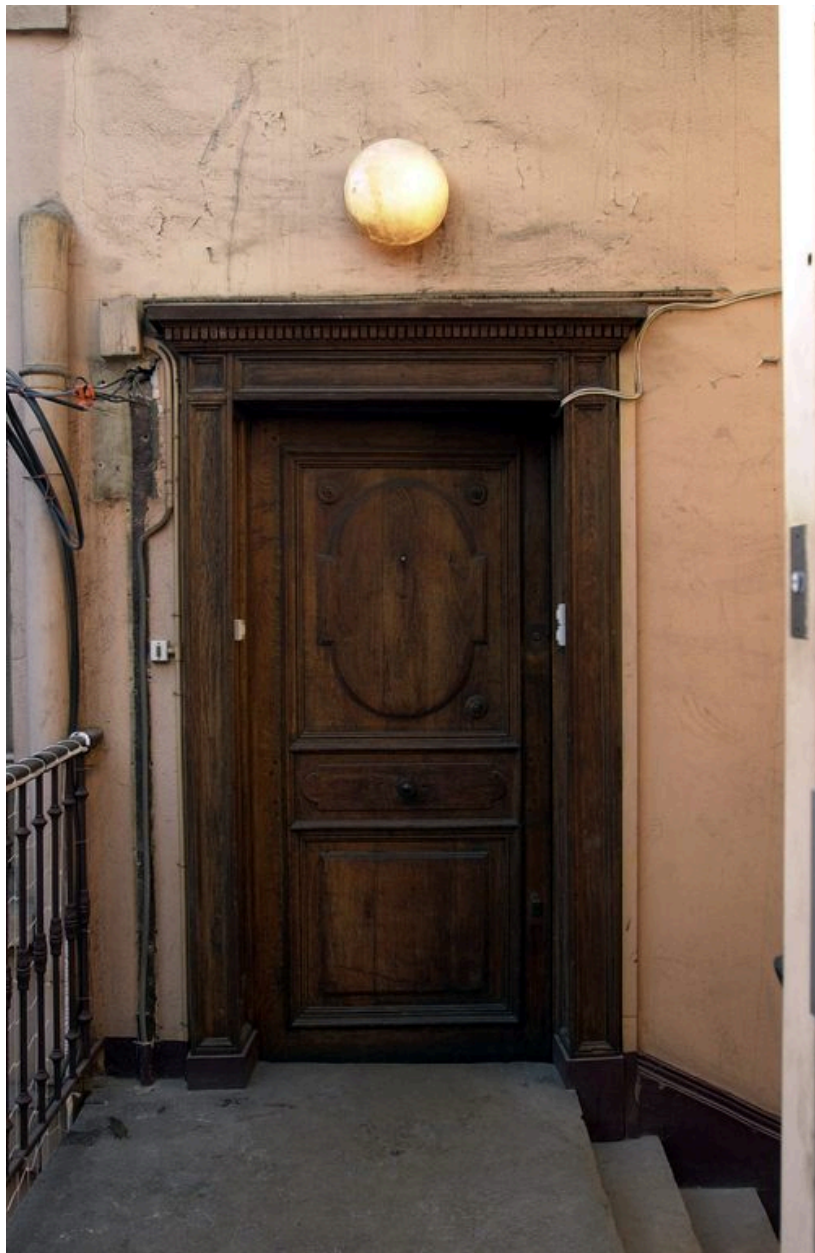
Escalier nord : porte palière du dernier étage
